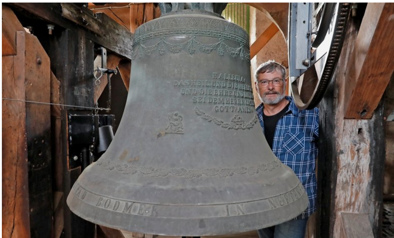
1843 erhielt die Kirche ein neues, dreiteiliges Geläut. Liegenschaftsverwalter Ueli Wirth leitete die Renovation von Schlagwerken und Steuerung der Glocken.
